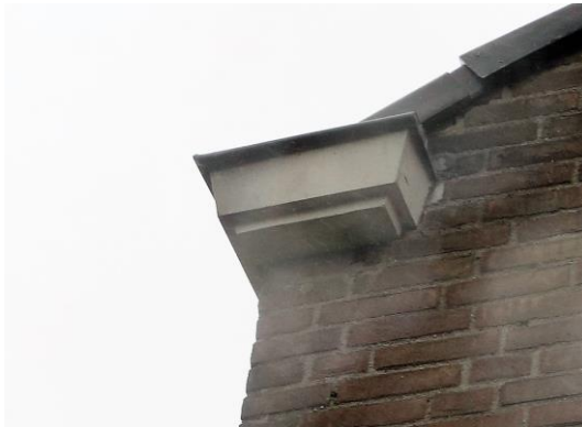
Figuur 7: Naadloos aansluitende aftimmering in deelgebied 1
