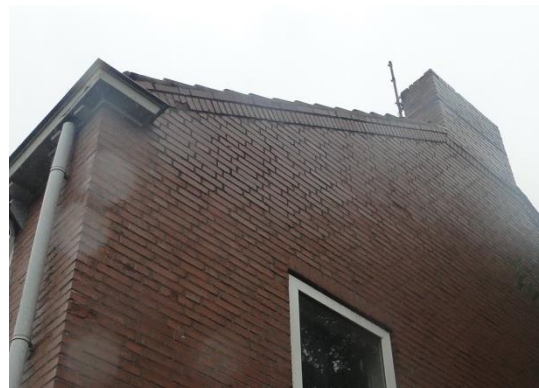
Figuur 8: Dichtgemetselde dakrand in deelgebied 2
