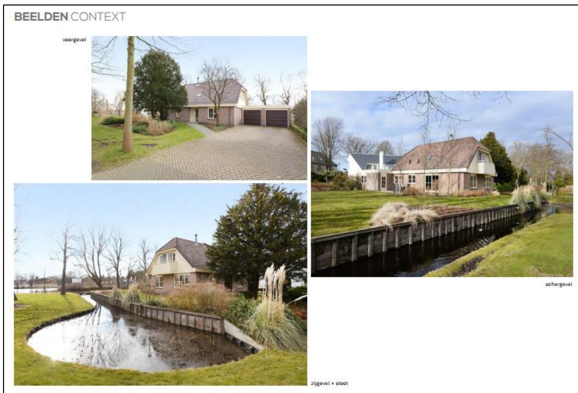
Figuur 7: Bestaande situatie woning – Van Manen
