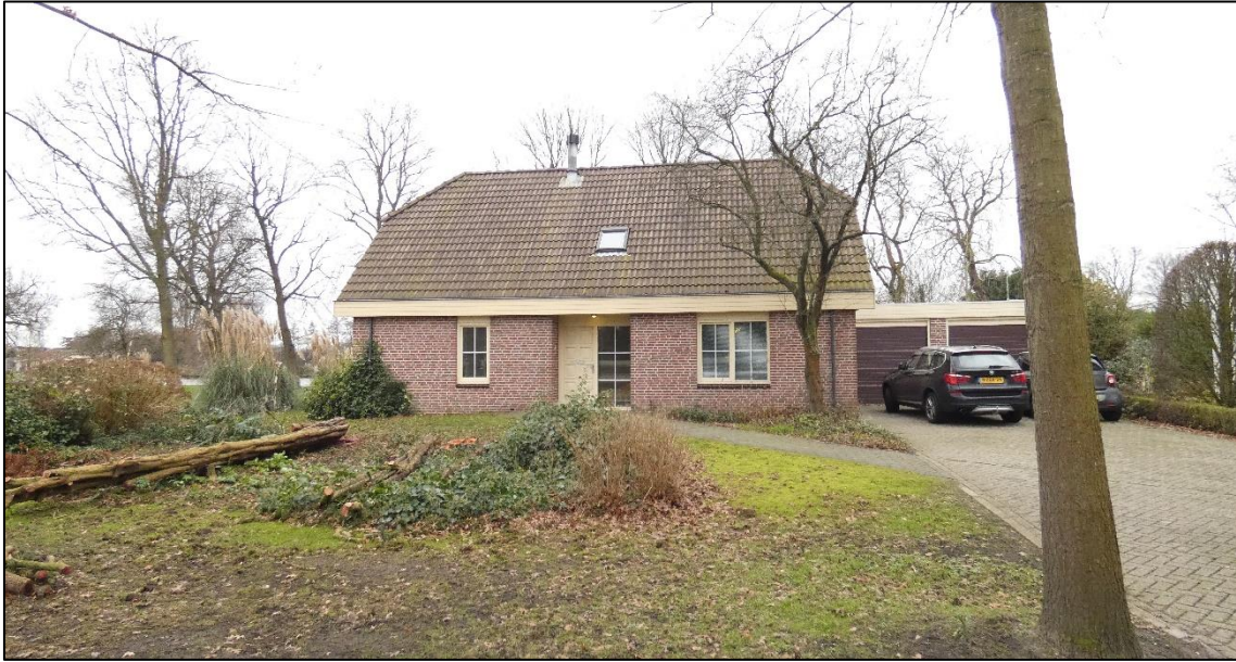
Figuur 2: Het voor aanzicht van de te slopen woning
