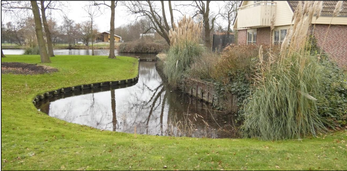
Figuur 9: De sloot naast het huis heeft verharde slootkanten en geen natuurlijk vegetatie
