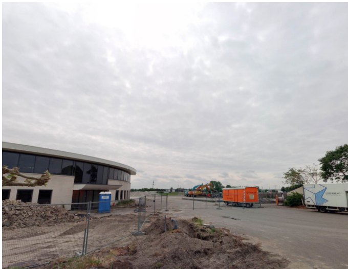
4. Plangebied ten tijde van sloopwerkzaamheden
