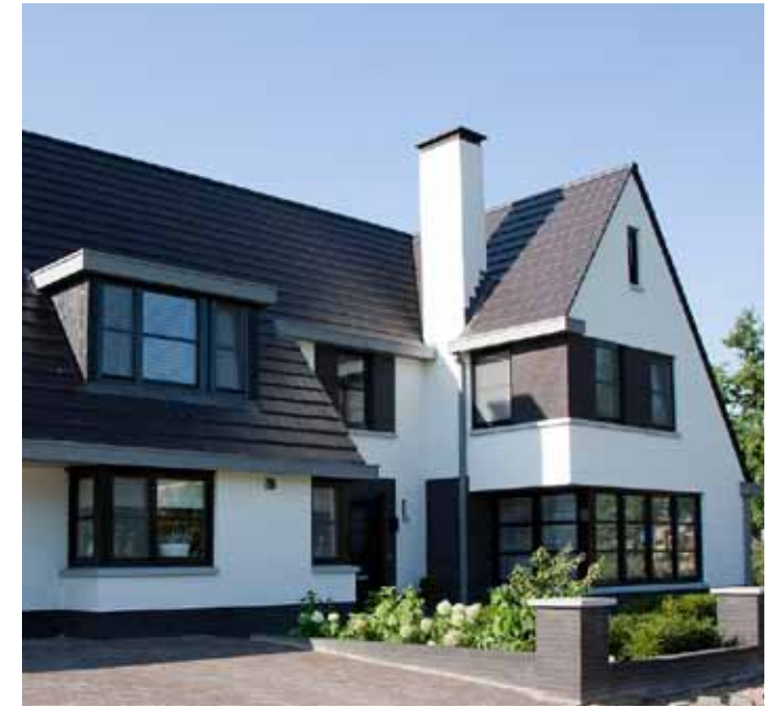
Asymmetrische kap met wisselende goothoogte
