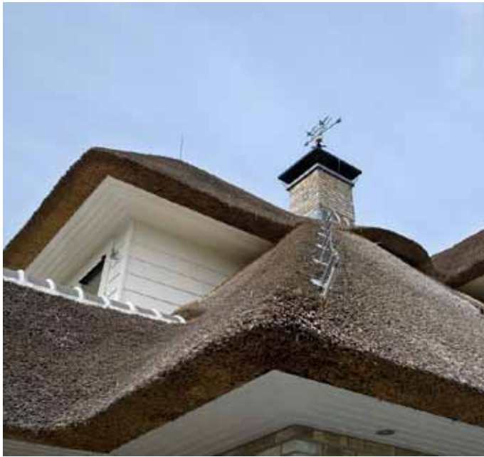
Samengestelde rieten kap
