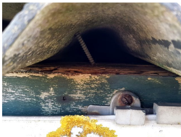
Voor vogels toegankelijke ruimtes onder het golfplaten dak boven de kennels en een detail
