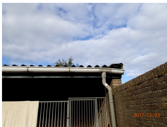
d) ruimte onder golfplaten dak bedrijfspand
