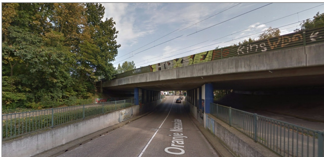
Figuur 3.2: Weergave geluidsscherm spoor ter hoogte van viaduct Oranje Nassaulaan in Warmond
