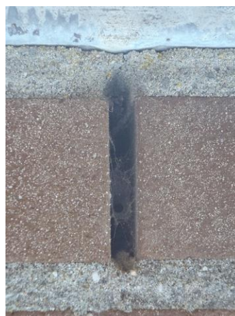
Afbeelding 3: open stootvoegen aan de zuidoostkant van het gebouw op de begane grond (links).
