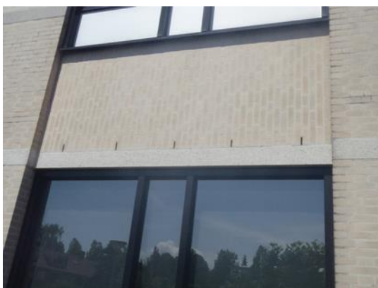
Afbeelding 3: open stootvoegen aan de zuidoostkant van het gebouw op de begane grond (links).
