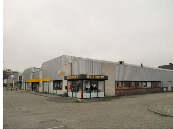
Figuur 3. Overzicht van de projectlocatie vanuit noordelijke richting.
