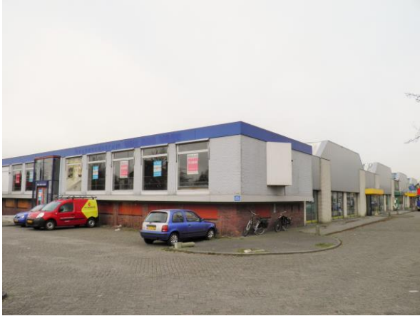
Figuur 2. Het bedrijfspand langs de Hoofdstraat wijkt in bouwstijl af van het achtergelegen deel.
