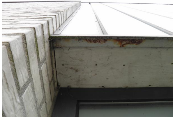
Figuur 9. De gevelbekleding en muur was naadloos op elkaar aangesloten.
