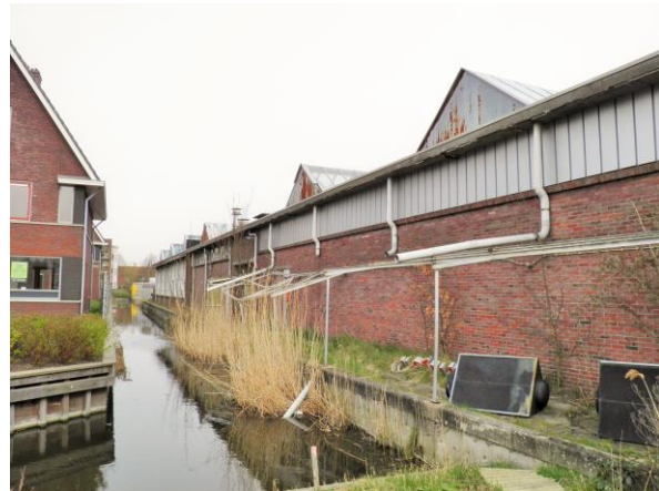
Figuur 5. Overzicht van de westzijde van het bedrijfspand.
