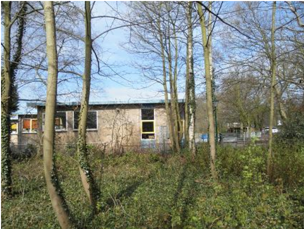
Te slopen schoolgebouw gezien vanuit jonge houtopstand.
