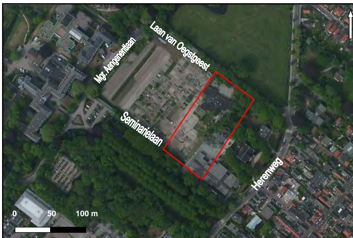
Figuur 1: Het plangebied (rood omlijnd) op een luchtfoto uit 2010 (bron: Bing Maps).
