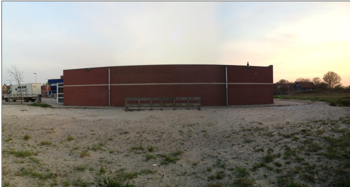
Figuur 2.3 Panoramafoto van de oostgevel
