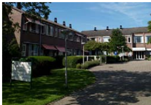
Aanleunwoningen vanaf de Endepoellaan.
