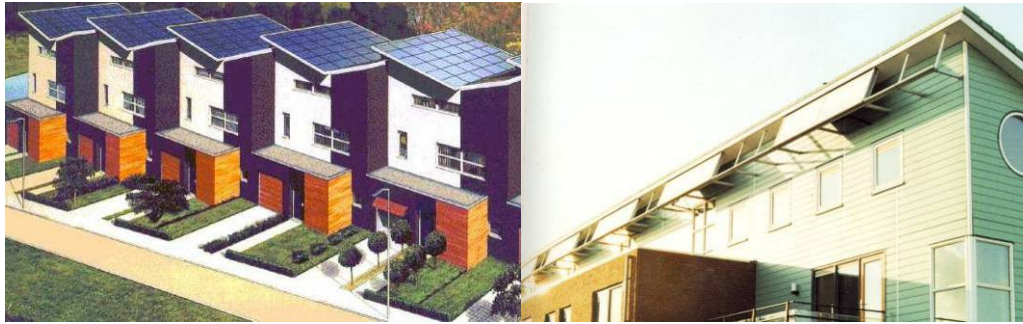
Figuur 3 - 6 PV panelen op daken en in zonwering
