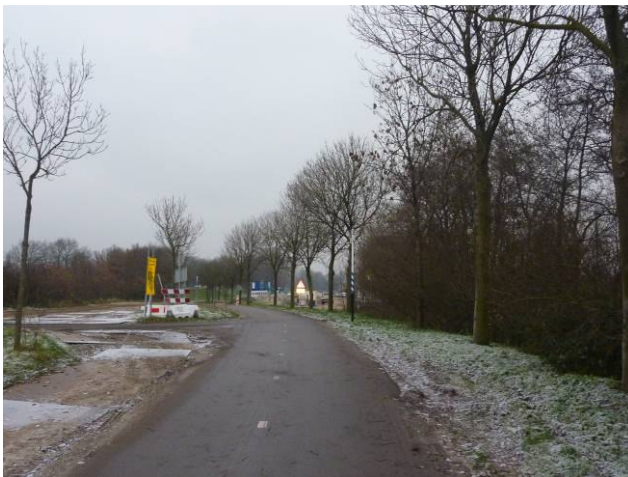
Zicht richting het noordoosten op het fietspad.
