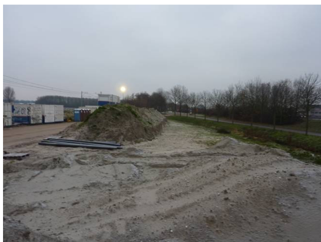
Zicht op de locatie, richting zuidwest.
