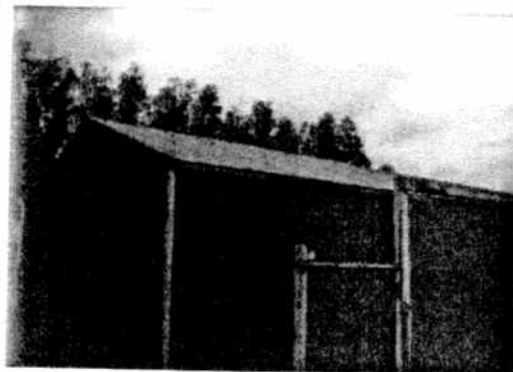
Foto 4 gesaneerd gedeelte dak van schuur achter de woning nr 6
