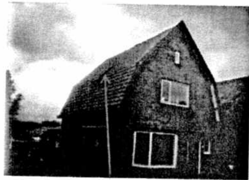
Foto 2 locatie waar ontluchtingskanaal heeft gezeten
