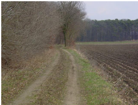
Zandpaden hebben een bol profiel. Om kuilvorming te voorkomen moet het zandbed droog blijven en dus goed afwateren.
