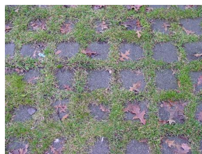
Met grasbetontegels of vergelijkbaar wordt de parkeerplaats in het landschap ingepast.
