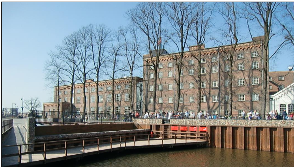
huidige situatie Portiersgebouw
