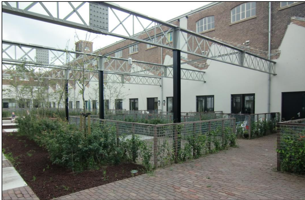
huidige situatie Beltmancomplex
