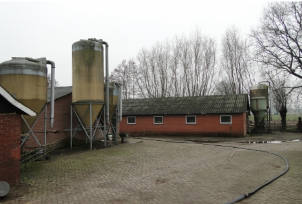
erf met zicht op gebouw 4 en 5
