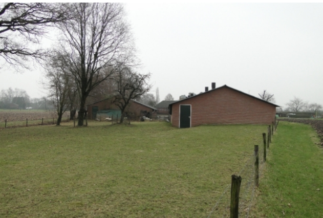
achteraanzicht gebouw 4 en 5
