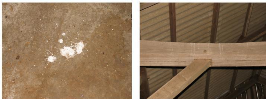
Figuur 3: kalksporen op de grond en op de spanten van de open kapschuur. Gezien het formaat van deze sporen kunnen deze wijzen op aanwezigheid van Steenuil ( Athene noctua ). (Foto's: SAB, 2010)
