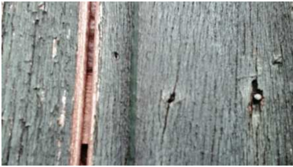
Detailopname van de buitenwand van het gebouw. Duidelijk zichtbaar is het regelwerk waarop de planken getimmerd zijn en de glaswoldeken er direct achter.
