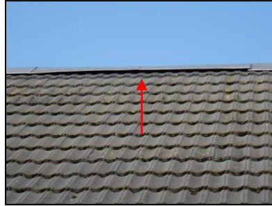
Figuur 12. Potentiële verblijfplaats vleermuizen.
