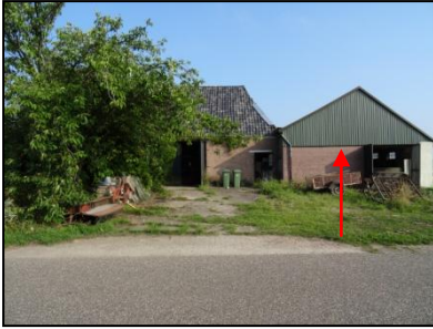
Figuur 11. Potentiële verblijfplaats vleermuizen.
