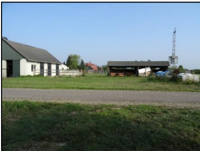
Figuur 6. Open houten kapschuur.
