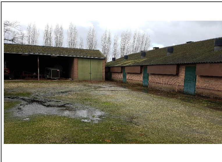
Foto 5: buitenterrein tussen bebouwing (gezien vanuit het oosten, 10 februari 2020)
