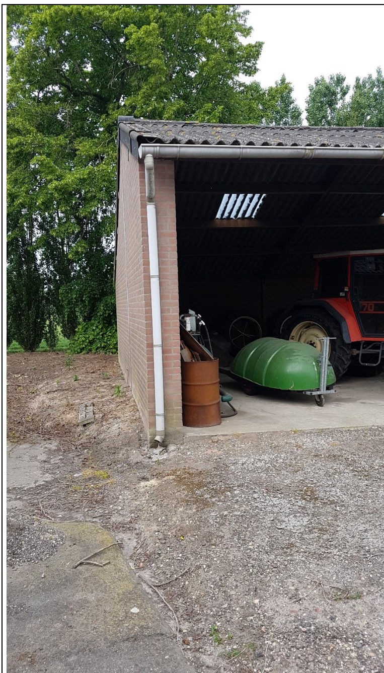
Foto 10: uitstroom regenpijp dakgoot westzijde machineloods (gezien vanuit het oosten, 19 mei 2020)
