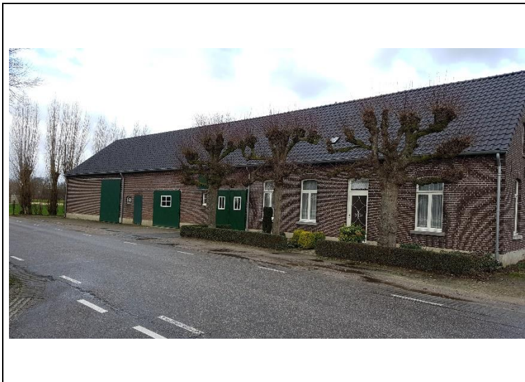
Foto 1: langgevelboerderij (gezien vanuit het oosten, 10 februari 2020)
