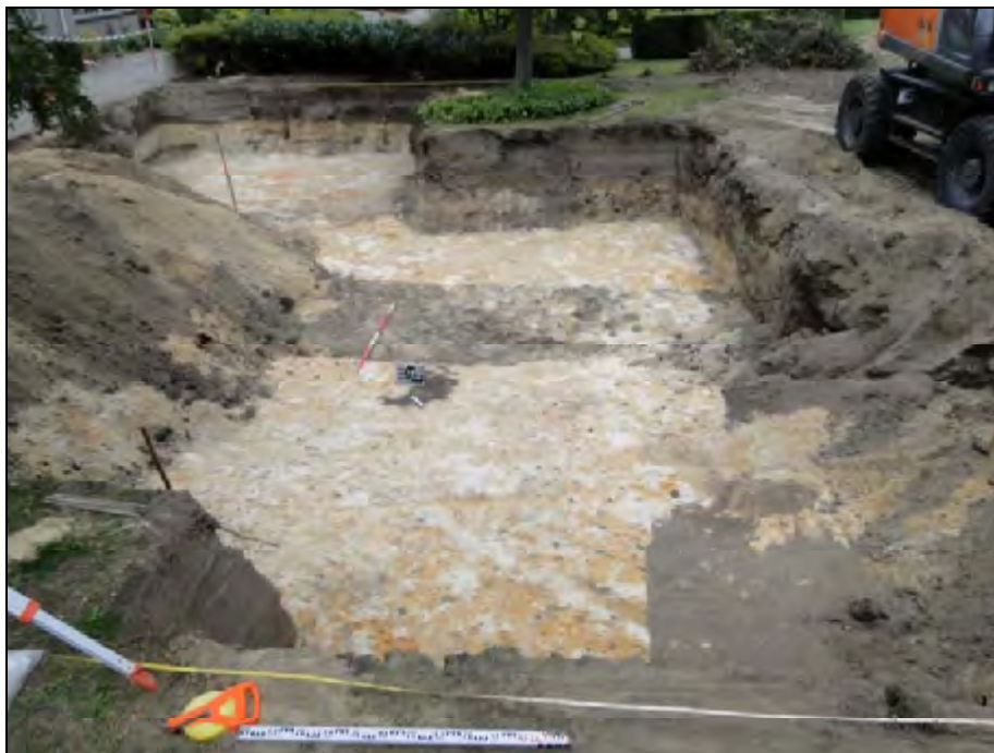
Afbeelding 43. Het aangelegde vlak in Strook II. Foto (Fotonummer 36) genomen naar het noordoosten.
