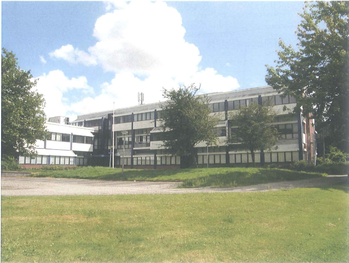
Figuur 3 Foto bestaand gebouw.
