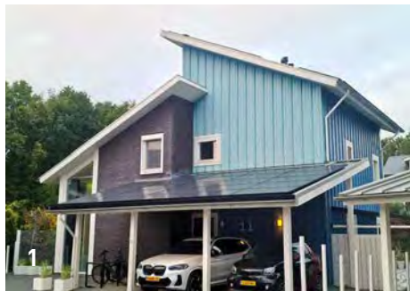
1. Heldere compositie van houten gevelbekleding en metselwerk en duidelijk zichtbare dieptewerking. Er is een duidelijk zichtbaar reliëf en dieptewerking in de gevel. 2. Detaillering van robuuste kap met fors dakoverstek. 3. Bijgebouw met vegetatiedak en fors boeiboord.
