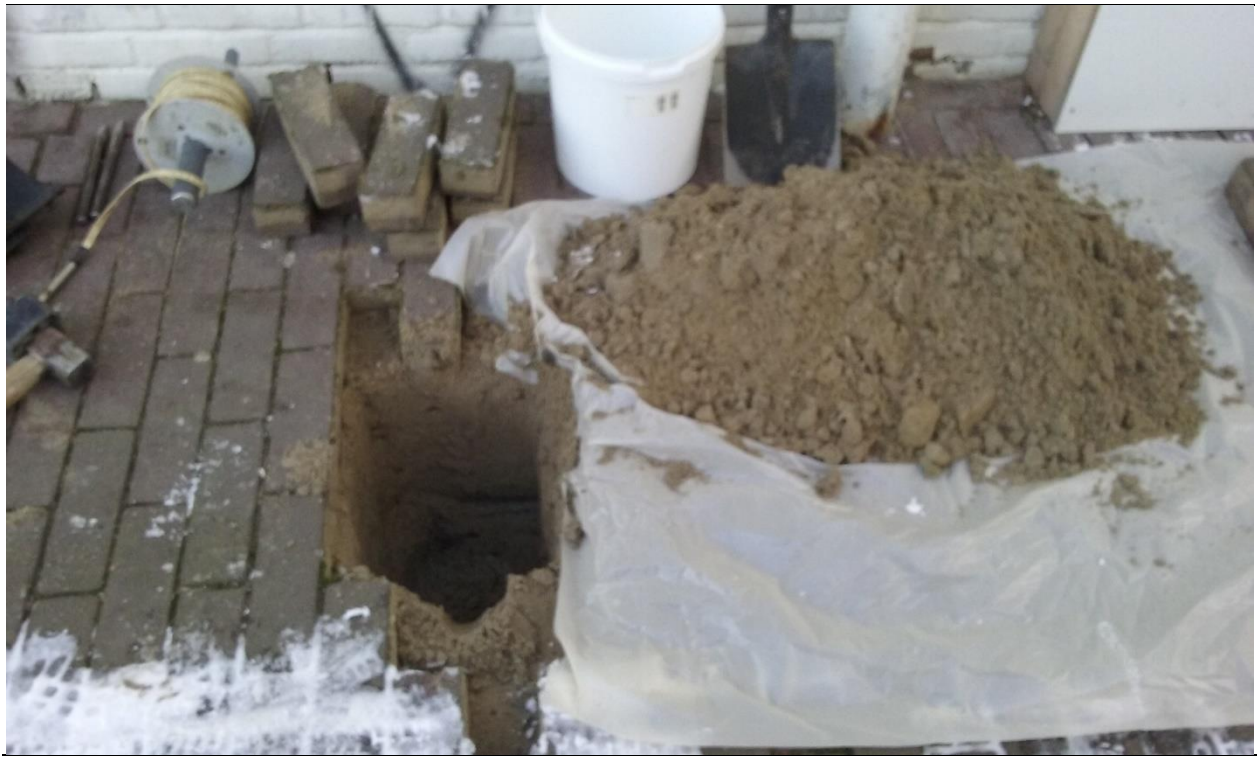
Foto B8.9 Asbestgat 20
