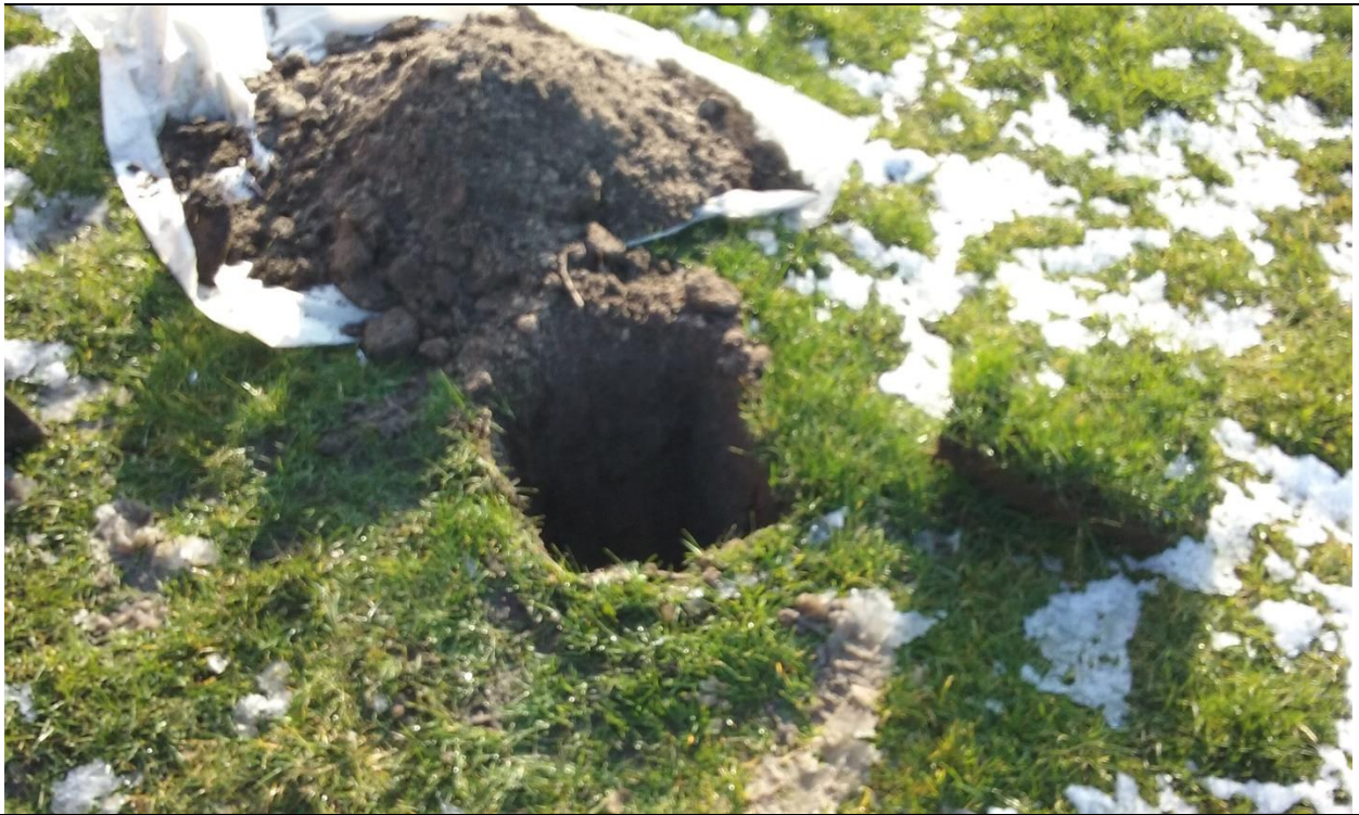
Foto B8.2 Asbestgat 29
