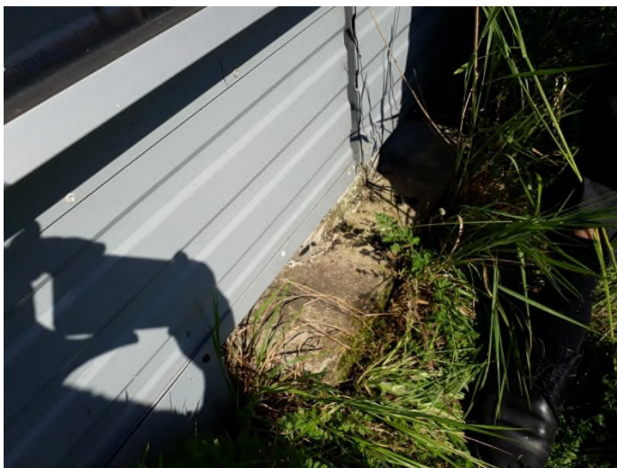
Figuur 4.3 Ruimte tussen geluidsscherm en grondniveau (foto Antea Group)
