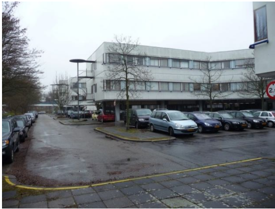
Figuur 2 Gebouw op kolommen
