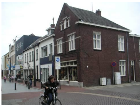
Stationsstraat hoek Boermansstraat
