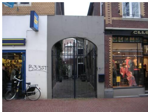
Steeg tussen Langstraat 4 en 6 (vakwerkgevel)
