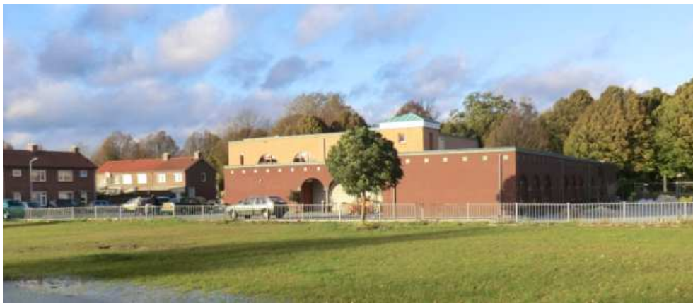
figuur: moskee aan Charitasstraat, na verbouwing
