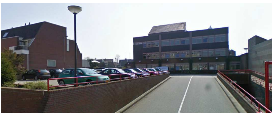
foto: oprit naar parkeerdek vanuit de Hogesteenweg met op achtergrond het stadhuis
