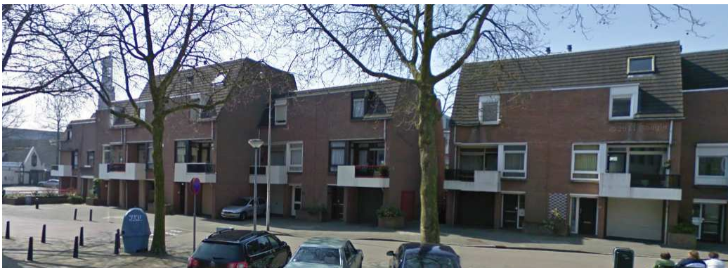
foto: woningen Hegstraat, deels boven parkeergarage
