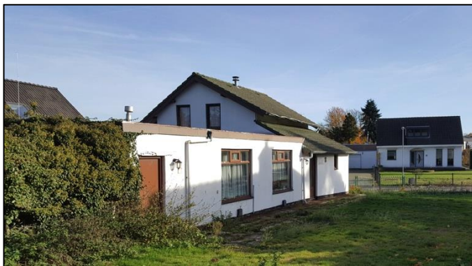
Foto's bestaande situatie
