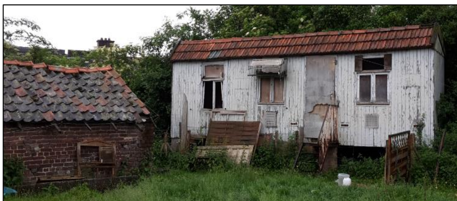
Foto's bestaande situatie
