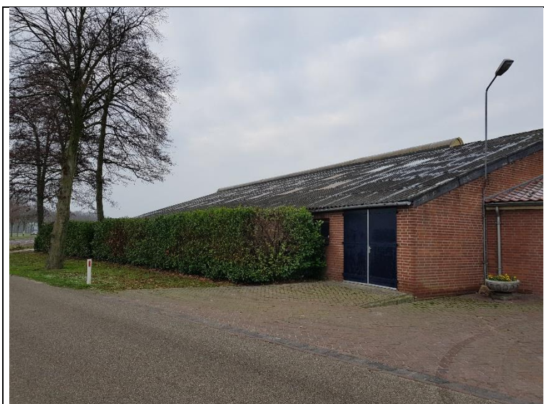
foto 5: zuidoostzijde schuur Pas 1 (14 december 2018)
