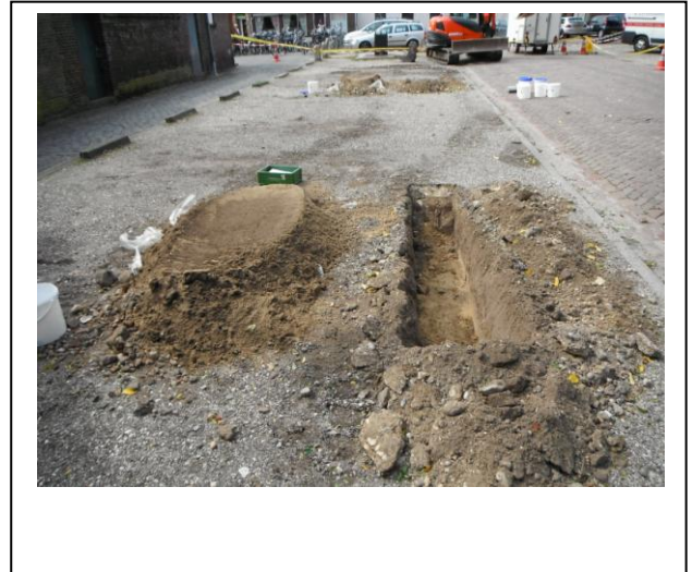
Foto 2. Asbestinspectiesleuf RE1-2
