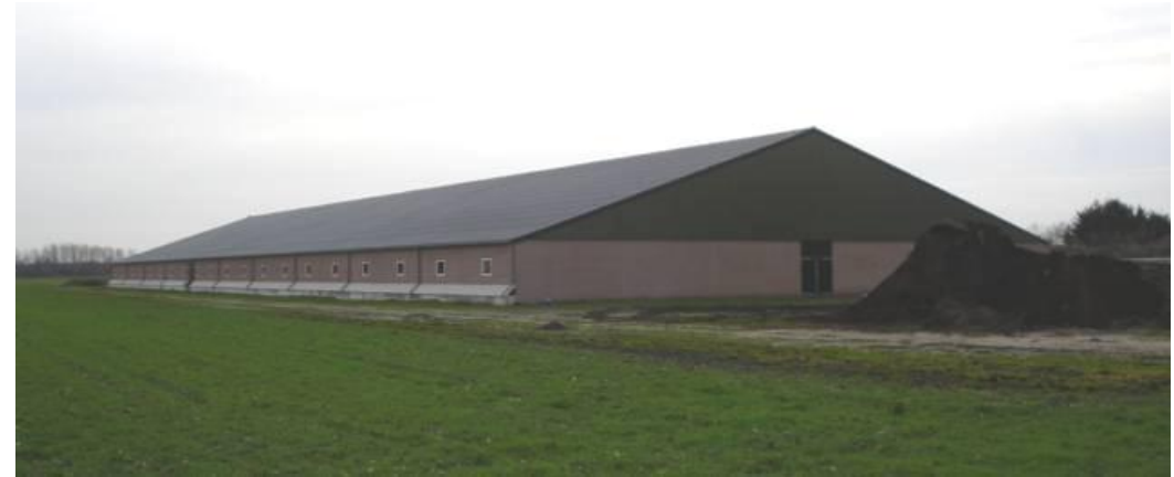
Deze stal heeft een lage goothoogte en een forse kap. De kopgevel is boven de goothoogte van een ander materiaal.
