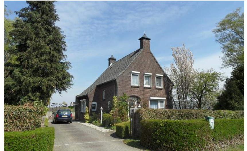
Eenvoudige woning met zorgvuldige detaillering.
