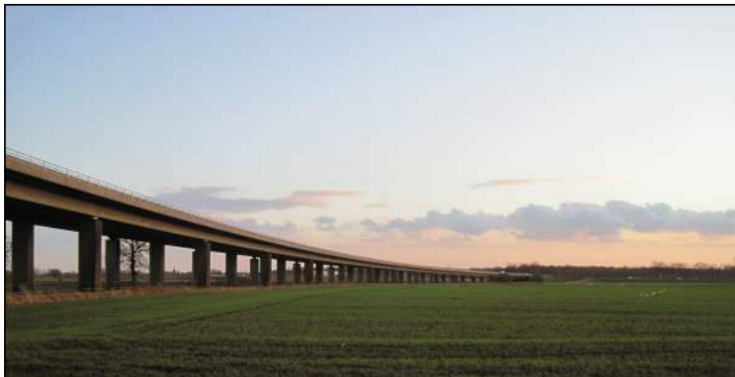
Afbeelding 24: brugaanloop naar de Maas
