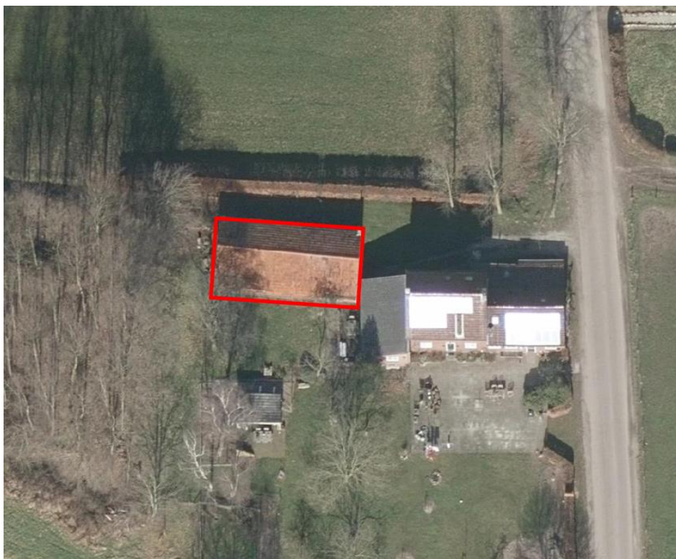
Figuur 2 Luchtfoto huidige situatie met varkensschuur rood omkaderd
