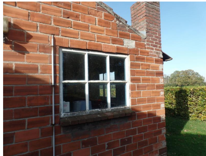
Binnen- en buitenaanzicht buitengevels: Geen spouwmuur. Aan de binnenzijde dezelfde steen als aan de buitenzijde. Ook de negge van het raamkozijn is slechts 20mm. zowel binnen als buiten.
