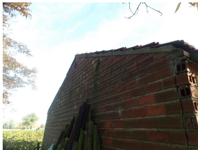
Achtergevel: geen dakoverstek maar cementlijst dik ca.20mm
