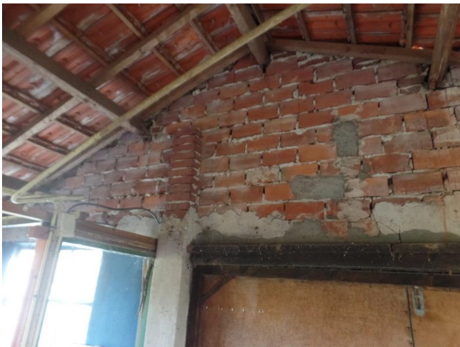
Binnen- en buitenaanzicht buitengevels: Geen spouwmuur. Aan de binnenzijde dezelfde steen als aan de buitenzijde. Ook de negge van het raamkozijn is slechts 20mm. zowel binnen als buiten.
