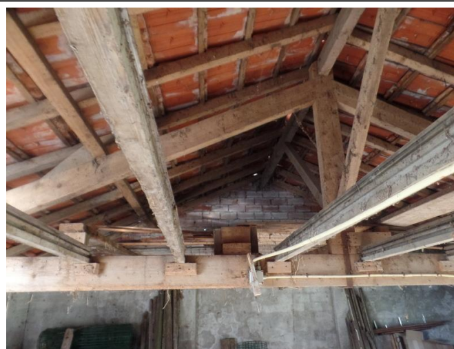
Geheel open ruimte: Geen zolder
