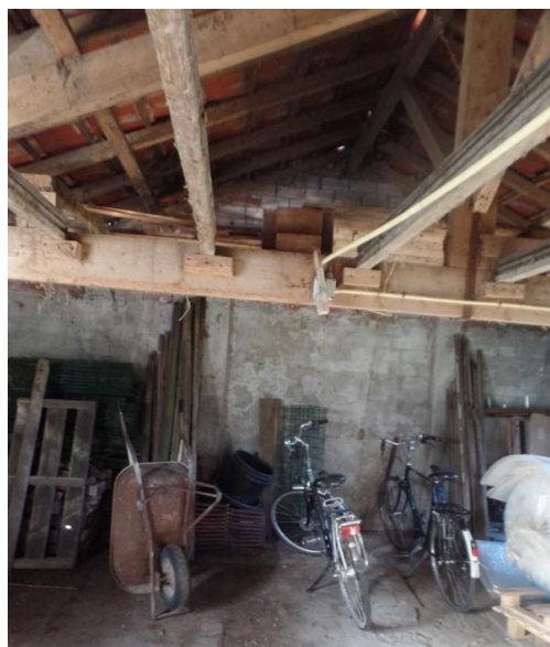
Geheel open ruimte: Geen zolder
