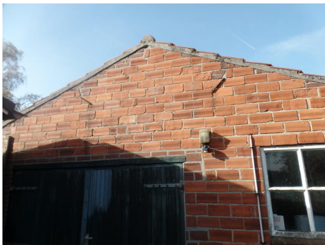
Vorgevel: geen dakoverstek maar cementlijst dik ca.20mm.
