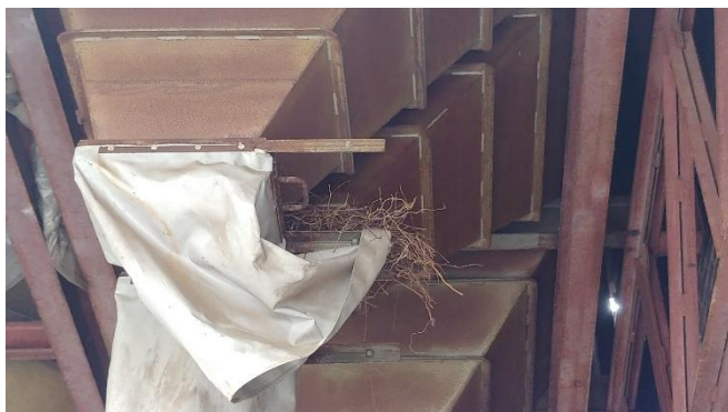
Figuur 12: Nest van een kauw, aangetroffen binnen de silofabriek
