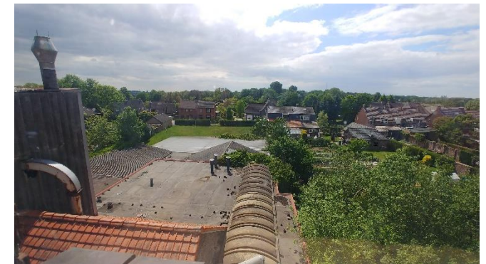
Figuur 11: Zuidzijde silofabriek gezien vanaf de silotoren. Duidelijk zijn de verschillende daktypen te zien.
