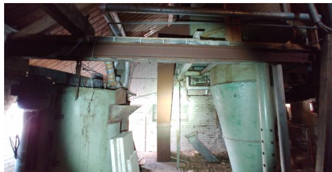
Figuur 8: Tweede verdieping van silotoren/bedrijfskantoor
