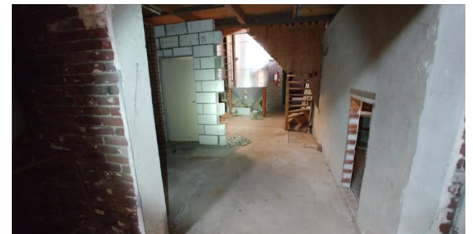
Figuur 9: begaande grond silotoren/bedrijfskantoor
