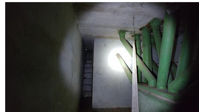
Figuur 14: Kelder onder silotoren
