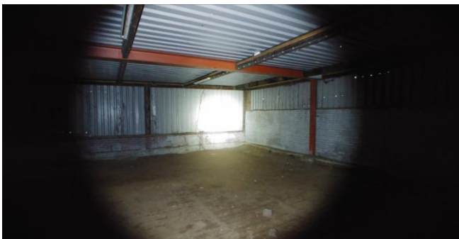
Figuur 7: Bedrijfshal aan de zuidzijde van de silofabriek
