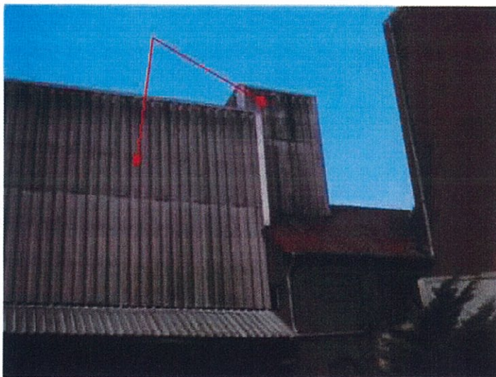
ruimte 1.4: impressie van de aanwezige gevelbeplating.
