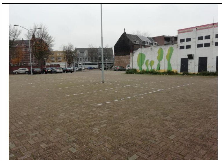
foto 2: overzicht terrein foto genomen vanaf de zuidwestzijde (26 november 2018)
