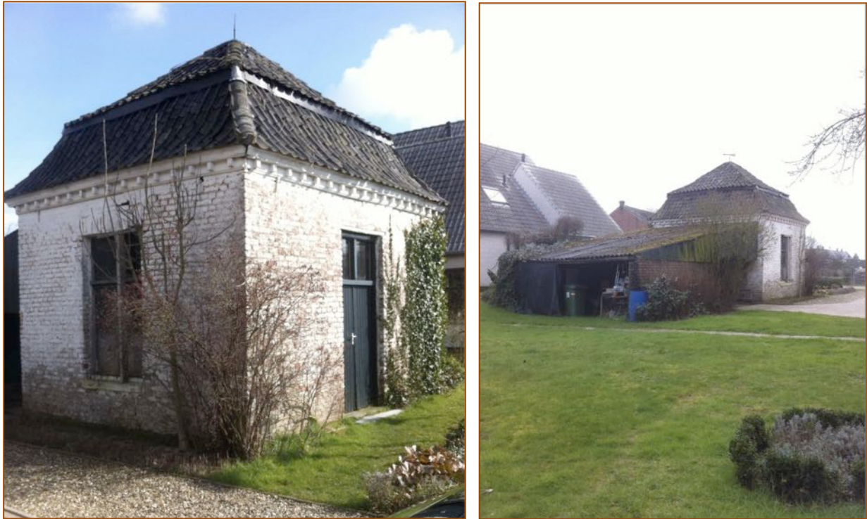
Afbeelding 2: links: voor- en zijgevel van het prieel; rechts: achterbouw garage en tuinopslag
