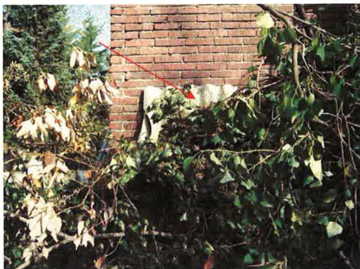
Foto 2: asbesthoudende golfplaten in de tuin van Steegstraat 28.
