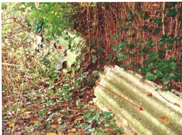
Foto 1: asbesthoudende golfplaten in de tuin van Steegstraat 28.
