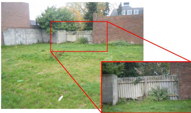
Afbeelding 2. Perceelsscheiding van asbestverdacht materiaal
