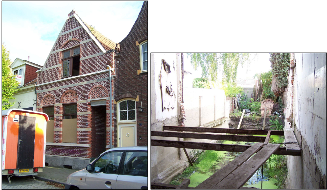
Bestaande situatie (waarbij alleen nog voorgevel en dak aanwezig zijn)
