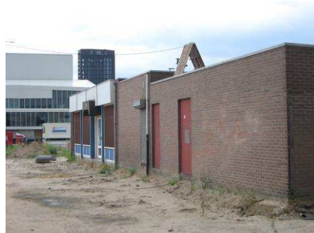
Achterzijde bebouwing Maaskade 11 t/m 16 en braakliggend terrein.
