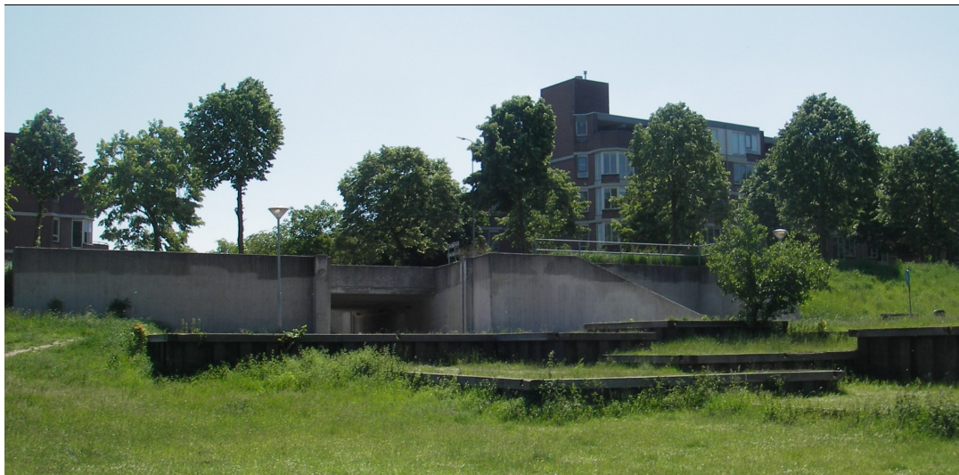
Figuur 3.3 De fietstunnel, gezien vanaf de rivierzijde
