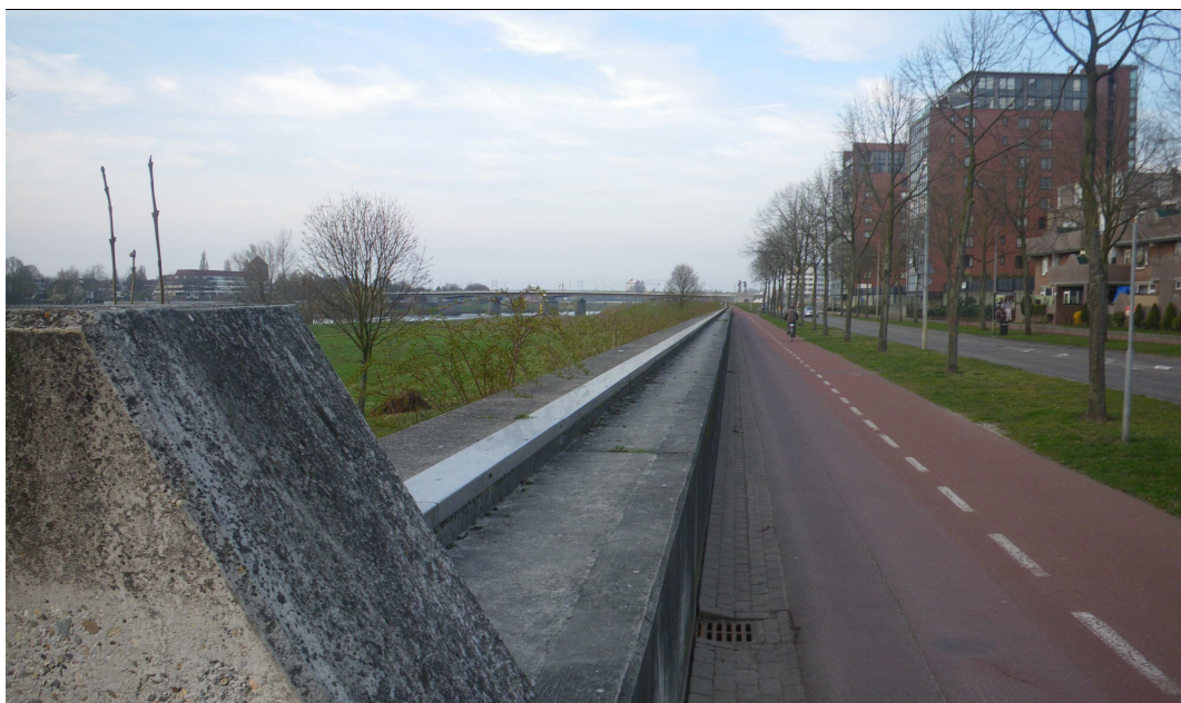
Figuur 3.2 De bestaande betonnen constructie, gezien vanuit het zuiden
