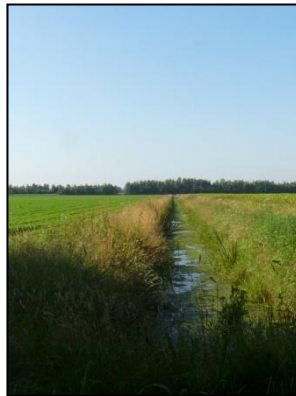
Figuur 10. De aanvoerleiding van de Langevenseloop.
