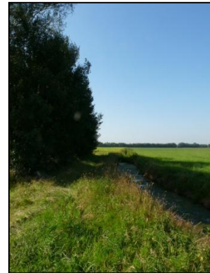
Figuur 11. De aanvoerleiding van de Langevenseloop.
